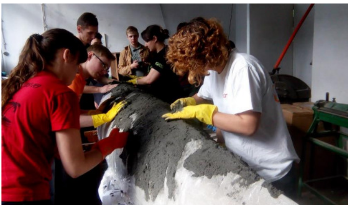
Rys. 4. Nakładanie pierwszej warstwy mieszanki betonowej
