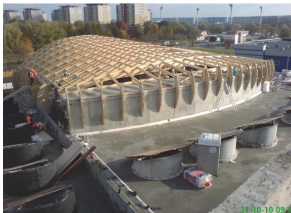
Zdjęcie 1.4.2. Montaż płatwi górnych i pozostałych elementów konstrukcyjnych dachu z drewna klejonego Regionalnego Centrum Dydaktyczno-Konferencyjnego i Biblioteczno-Administracyjnego Politechniki Rzeszowskiej w Rzeszowie
