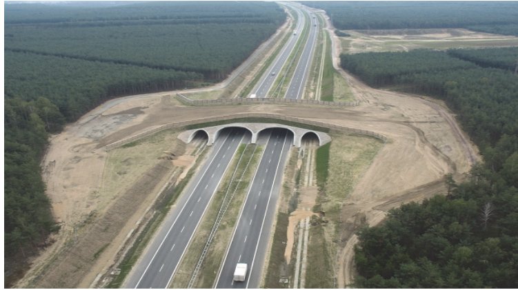
Zdjęcie 6.9. Widoczne przepusty dolne dla zwierząt po obu bokach dróg
