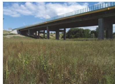
Przejścia dolne dla zwierząt – estakada
