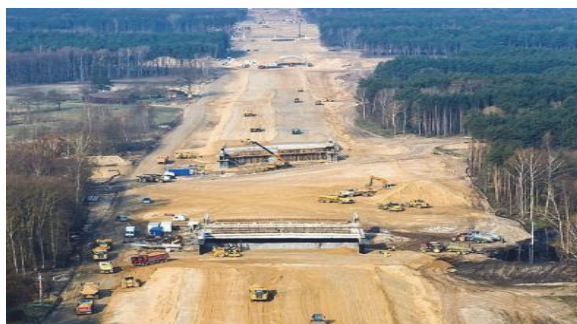
Zdjęcie 6.10. Wykonywania przepustów dla zwierząt małych i średnich (z lewej) dla zwierząt dużych (z prawej)
