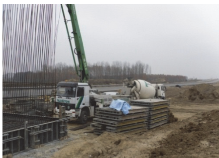
a) podawanie mieszanki przez pompę do betonu
