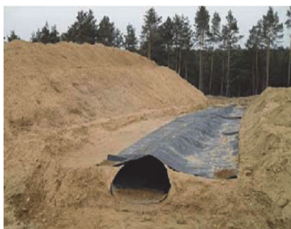
Zdjęcie 6.10. Wykonywania przepustów dla zwierząt małych i średnich (z lewej) dla zwierząt dużych (z prawej)
