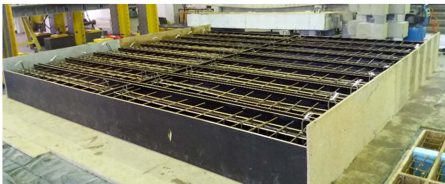
Rys. 2.6. Formy szalunkowe z ułożonymi szkieletami zbrojenia Fig. 2.6. Formworks with reinforcement skeletons
