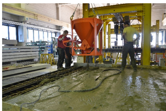
Rys. 2.7. Betonowanie belek Fig. 2.7. Casting of beams
