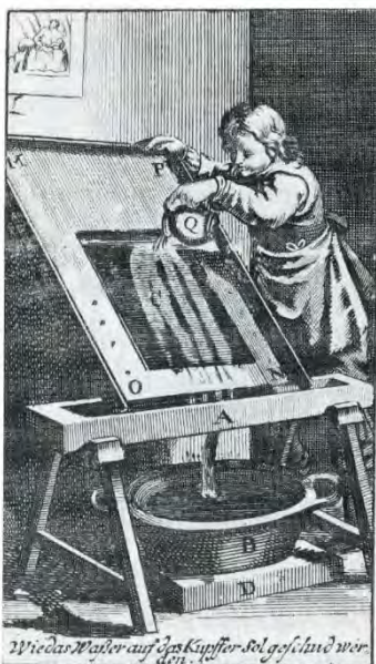
Rys. 3.63. Trawienie płyty miedzianej, miedzioryt, ok. 1790 r.
