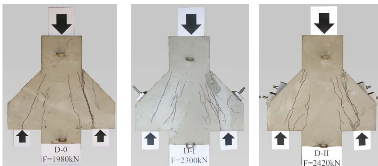
Rys. 3.22. Widok zniszczonych wsporników serii D Fig. 3.22. View of corbels series D after failure
