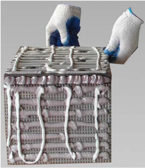
Nakładanie kleju na akcesorium Placing of the glue on accessory
