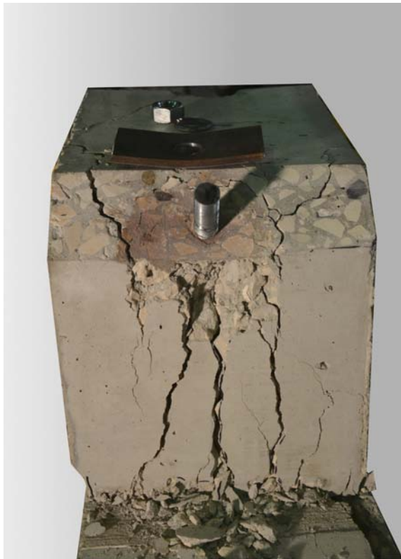
Powierzchnia ściskana z widocznymi rysami / Compression surface with visible cracks
