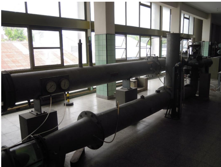
Figura 38. Imagen del banco de ensayos antes de las modificaciones.
