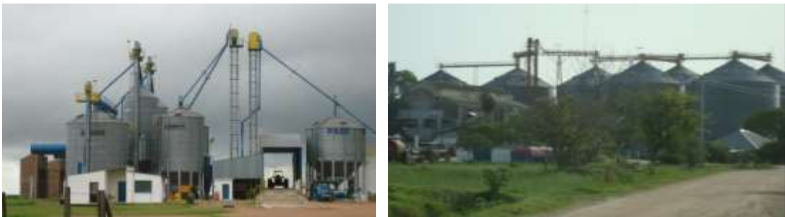
Figura 75. Secador y Silos en San Fernando y La Planta en Arrozal 33. Fotos de la autora.
