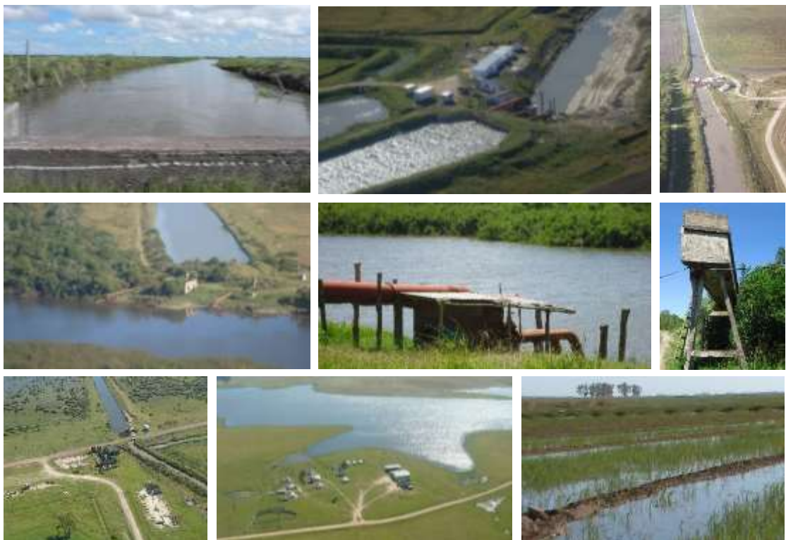
Figura 29. Obras de ingeniería hidráulica. Bombas de levante en Arrozal 33, Canal mayor de CIPA Olimar, toma de agua y bomba Krupper en el Río Olimar, canal de riego, represa los Chanchos y riego en campos de cultivo.
