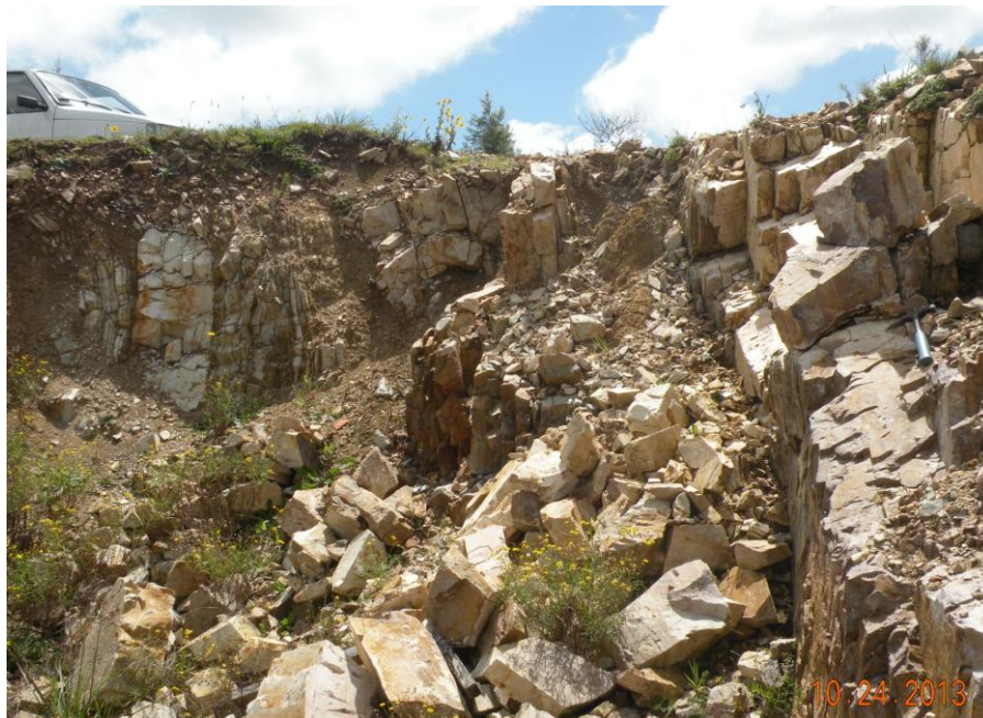
Figura 32: Imagen de la cantera ubicada frente a la bodega, apreciando claramente el bandeo característico de las rocas.
