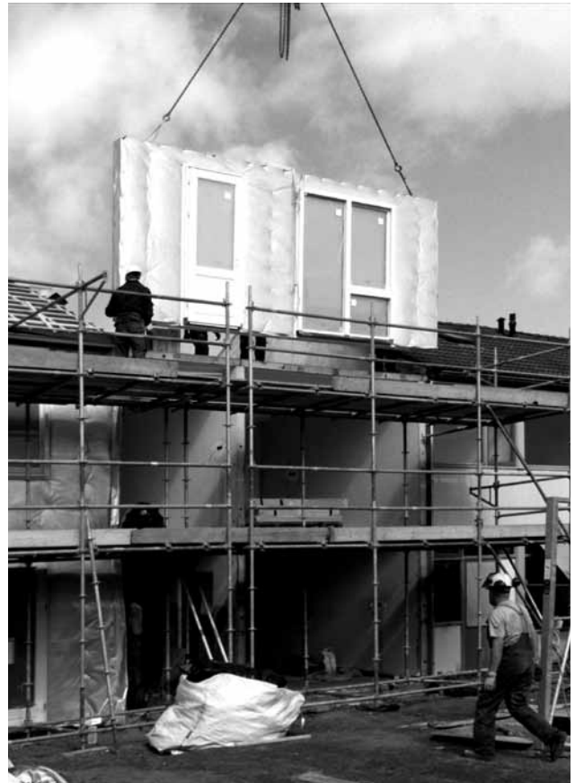
Renovación de 115 viviendas tipo doorzon para consorcio Zorgeloos Wonen en Ulft. Grupo Renovatief. Ulft, 2014. Foto publicada en www.renovatief.com .
