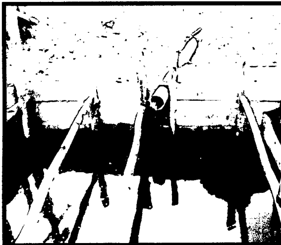
Figura 06. Poza donde se almacena el lixiviado que genera el relleno sanitario manual.
