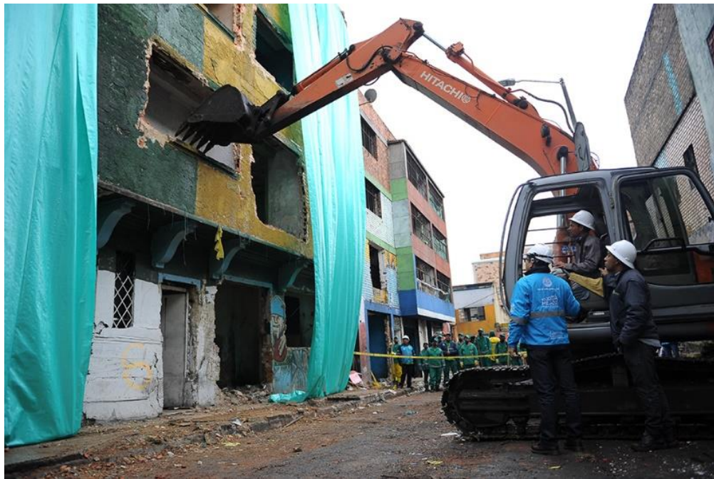
Figura 26. Inicio de la demolición del Bronx.
