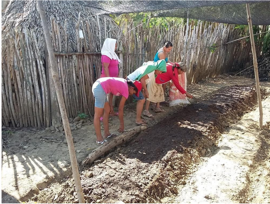
Foto 12 Mujeres construyendo patio productivo 47
