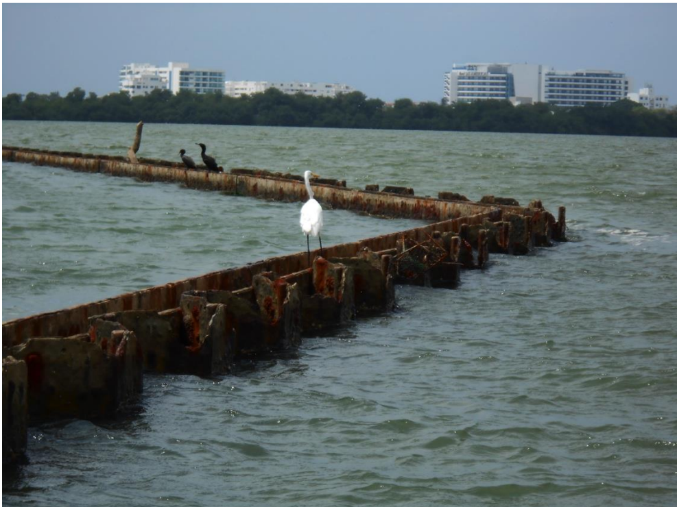
Fotografía 2. Canal que permite la acción de Bocana Estabilizada.
