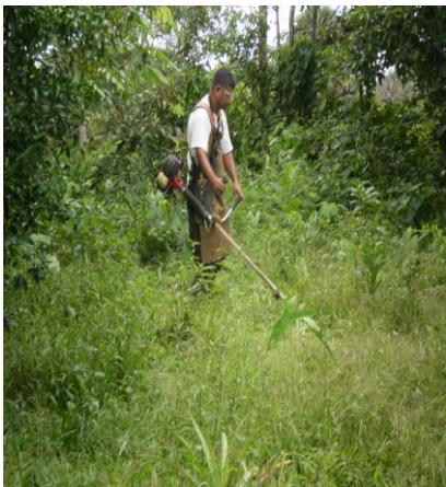
Figura 4. Limpieza de terreno
