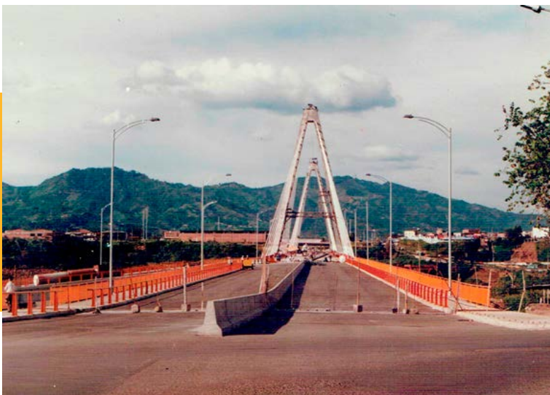
Imagen 21. Viaducto César Gaviria Trujillo en culminación de obras para circulación de vehículos y peatones, 1997. Vista, Pereira-Dosquebradas. Fuente: Patiño, M (2020). Archivo familiar Patiño Barbosa. Caption: Ejemplo de monumento Traza, es un puente de 704 metros de largo y posee una altura de 54 metros, es reconocido por ser una estructura que conecta los municipios de Pereira y Dosquebradas.
