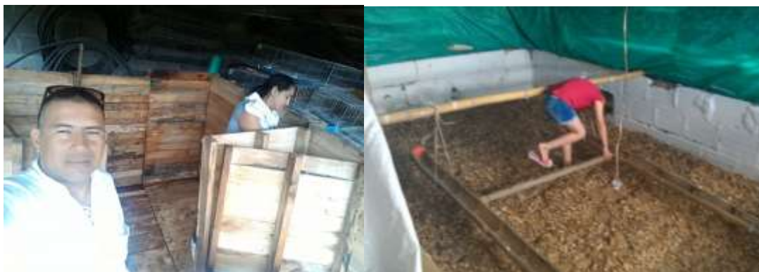
Figura 22. Construcción y preparación del galpón para los pollos.
