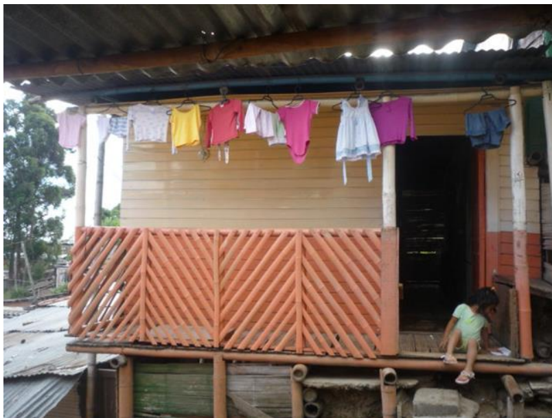
Fotografía 20. Casa de doña Elizabeth González. Fuente: Registro propio
