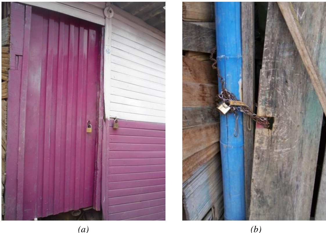
Fotografía 16. Seguridad frecuentemente encontrada en el barrio el Plumón. Fuente: Registro propio
