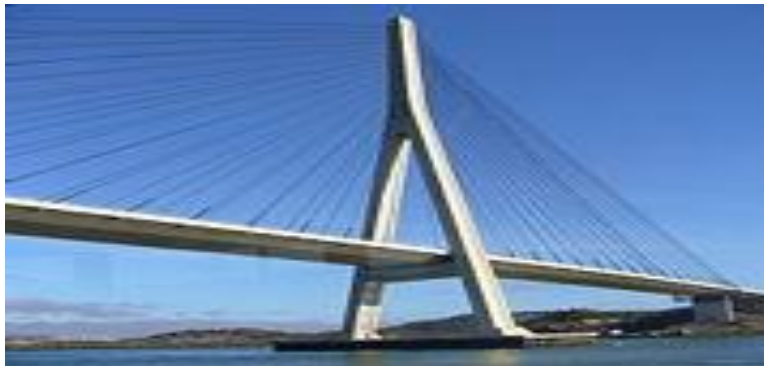
Figura 1. Puente Internacional sobre el río Guadiana
