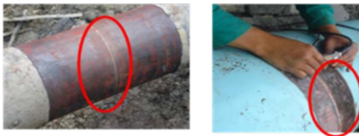
Figura 2.4: Ejemplo de Soldaduras. Fuente CIC.
