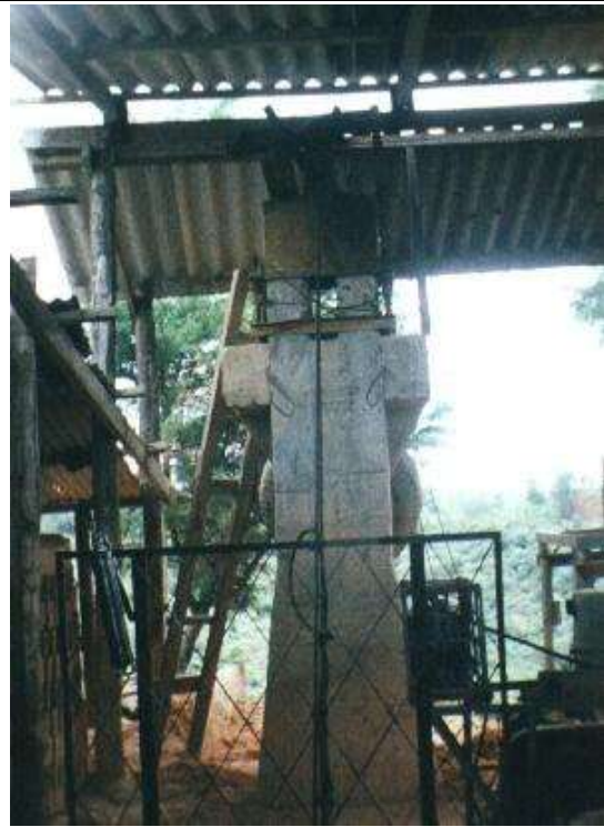
Torreta, por donde pasa el cable que hala el cajón desde la otra montaña.
