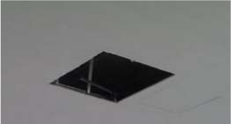
Figura 38 Vista techo falso
