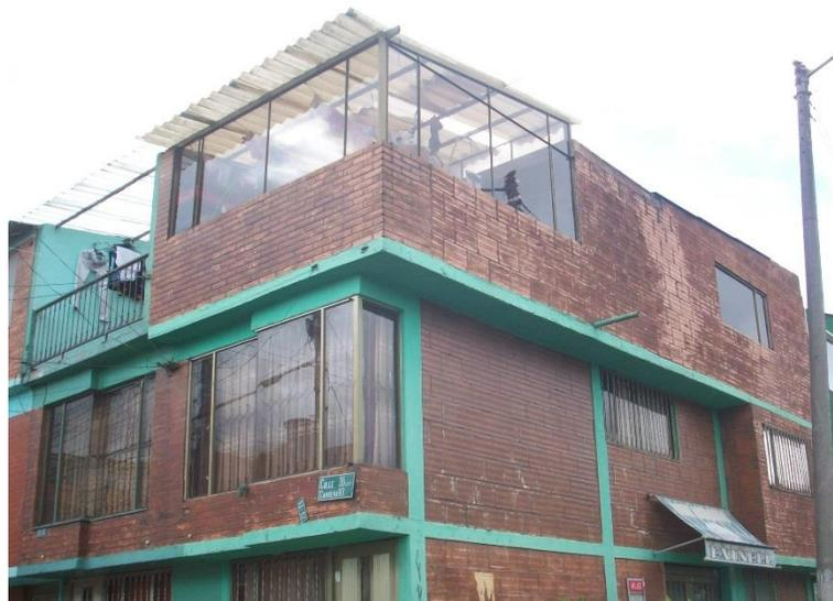
**Fotografía 24.** Parapetos en la cubierta sobre el voladizo
