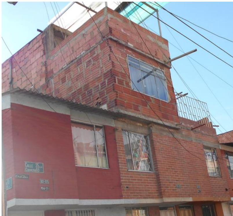
**Fotografía 7.** Irregularidades en el espesor del mortero de pega
