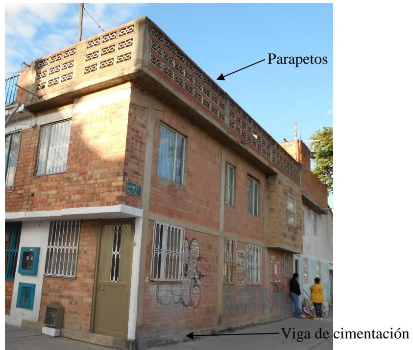
**Fotografía 25.** Parapetos sin elementos de anclaje
