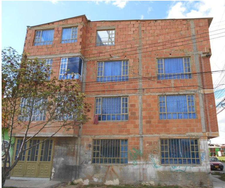
**Fotografía 2.** Sistema de losa de entresijo apoyado directamente sobre la mampostería sin vigas de amarre
