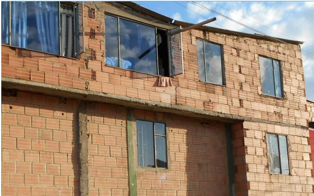
**Fotografía 6.** Combinación de bloque #5 y ladrillo en fachadas
