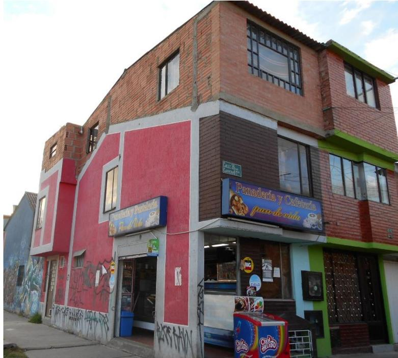
**Fotografía 4.** Tercer nivel en mampostería no confinada y desplazada del plano de acción
