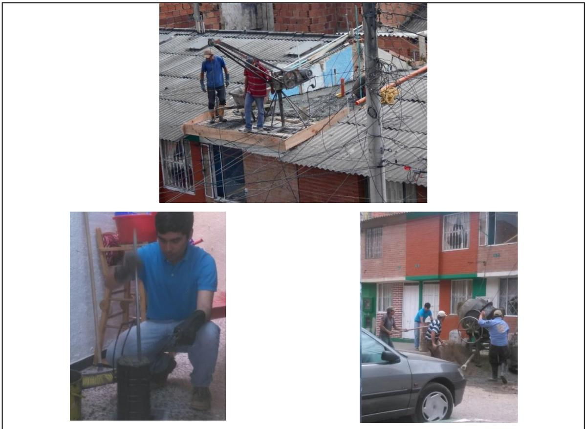
En las tres pruebas que se realizaron se obtuvieron resistencias bajas del concreto (Ver Tabla 41), por lo que para el modelamiento matemático se trabajó con una resistencia baja del concreto, en tanto que la calidad del acero pudo ser constatada en campo en aquellas varillas que se encontraban a la vista, a las cuales se les pudo leer su valor de resistencia impresas en éstas.
