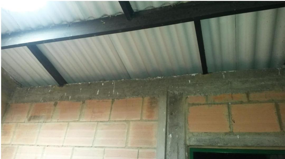
**Fotografía 22.** Estructura de cubierta sobre perfiles metálicos apoyados en columnetas
