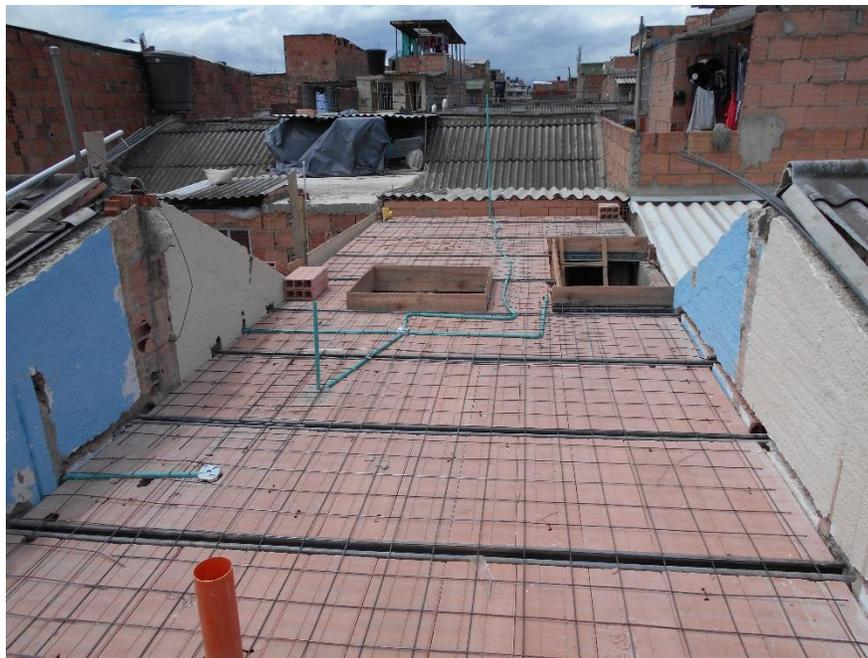
**Fotografía 12.** Apoyo del perfil metálico directamente sobre el bloque #5
