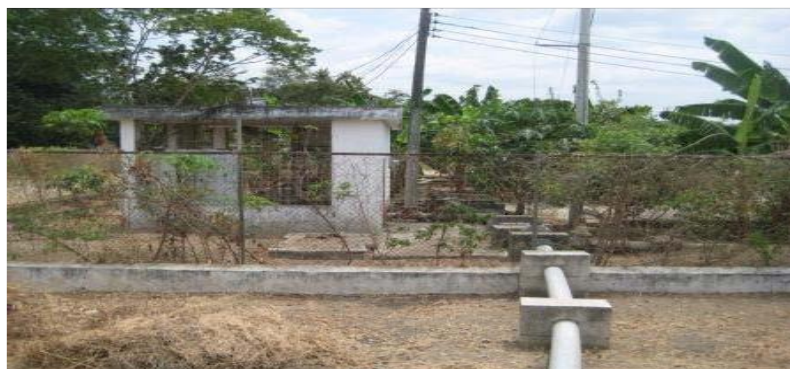
Figura N° 2.5.- Estación de bombeo
