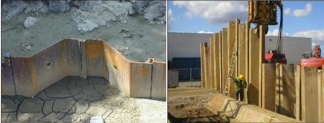
FIGURA 8: Ejemplos de pantallas de tablestacas
