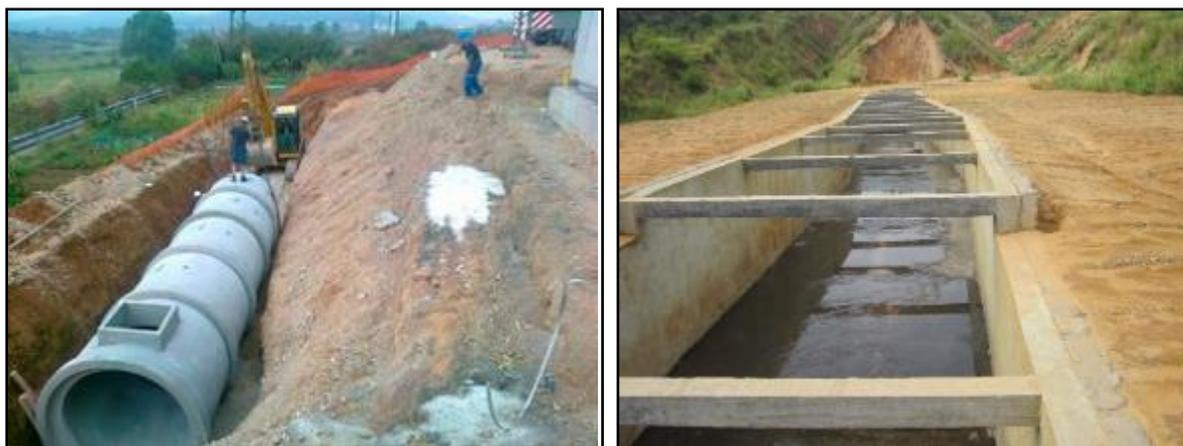
FIGURA 19: Ejemplos de tubería de hormigón circular diámetro grande, enterrada (izquierda) o canal rectangular abierto (derecha)
