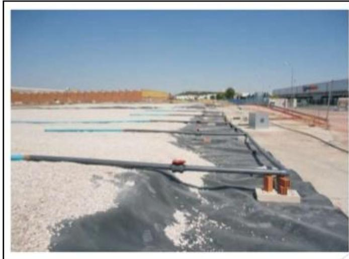
FIGURA 12: Sistema de extracción de vapores
