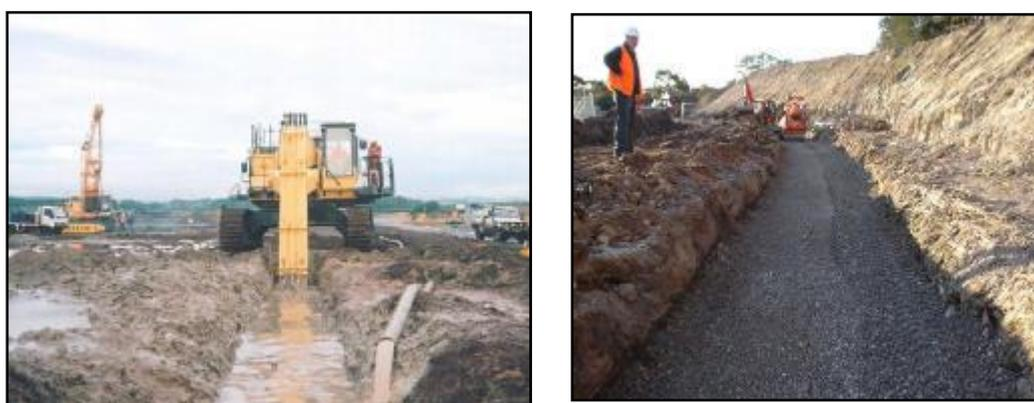
FIGURA 6: Establecimiento de una pared de lechada bentonita-cemento.
