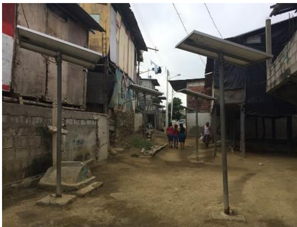
Foto 4.- Estado de viviendas y paneles solares
