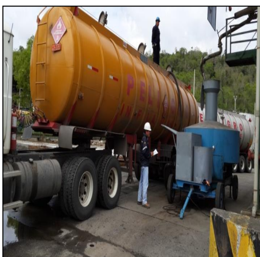
Calibración de medidores en brazos de Llenaderas (Llenaderas)
