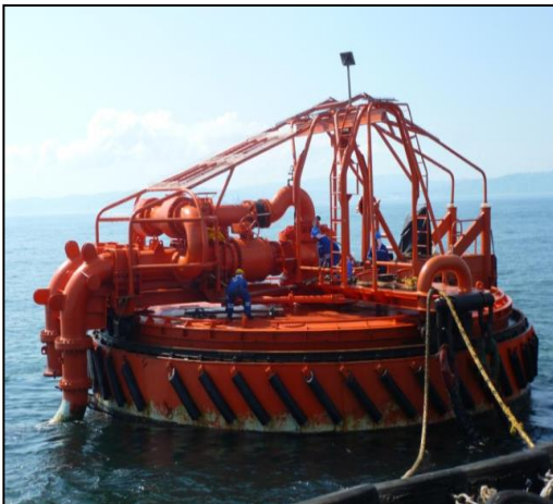
Inspección bimensual a monoboya del TMB.
