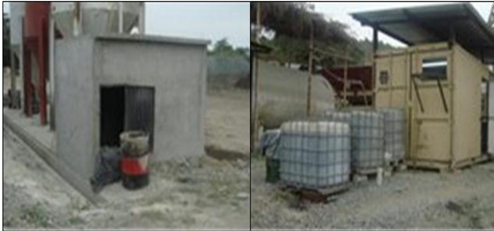
Fuente: Planta de Hormigón San Carlos Elaboración por: Ing. Ind. Duarte Nivelá Ángela Larizza
