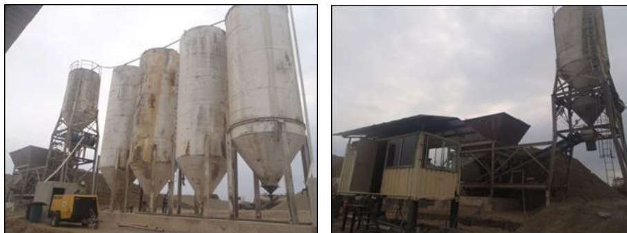
Fuente: Planta de Hormigón San Carlos Elaboración por: Ing. Ind. Duarte Nivelá Ángela Larizza
