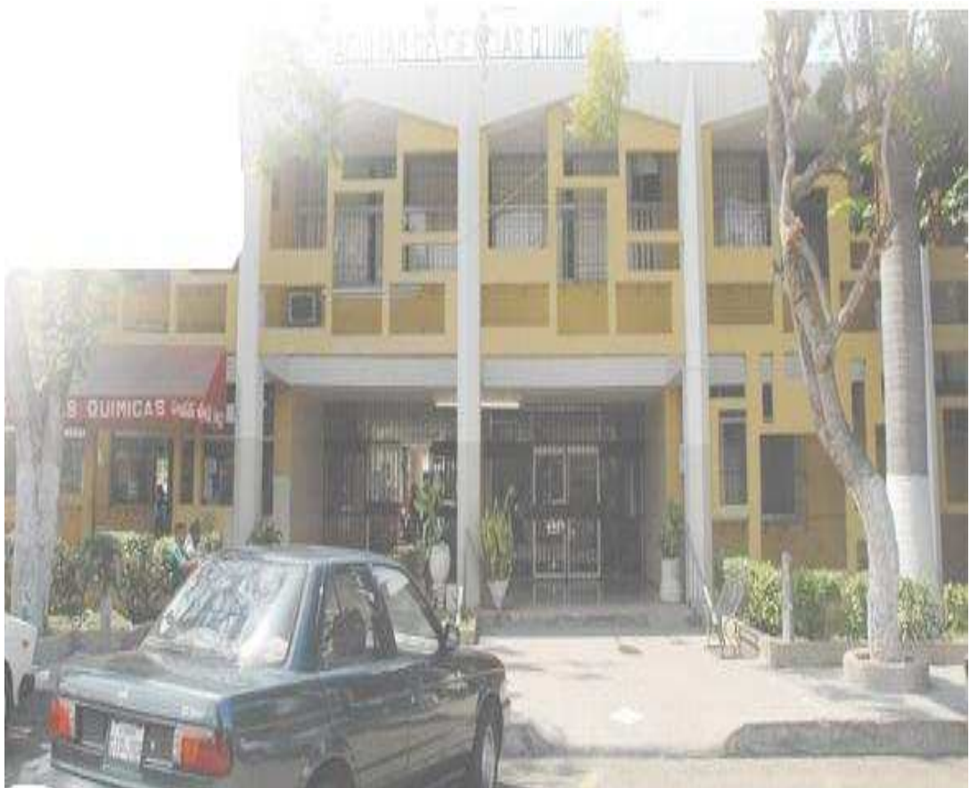
Gráfico #1 Edificio de la Facultad de Ciencias Químicas
