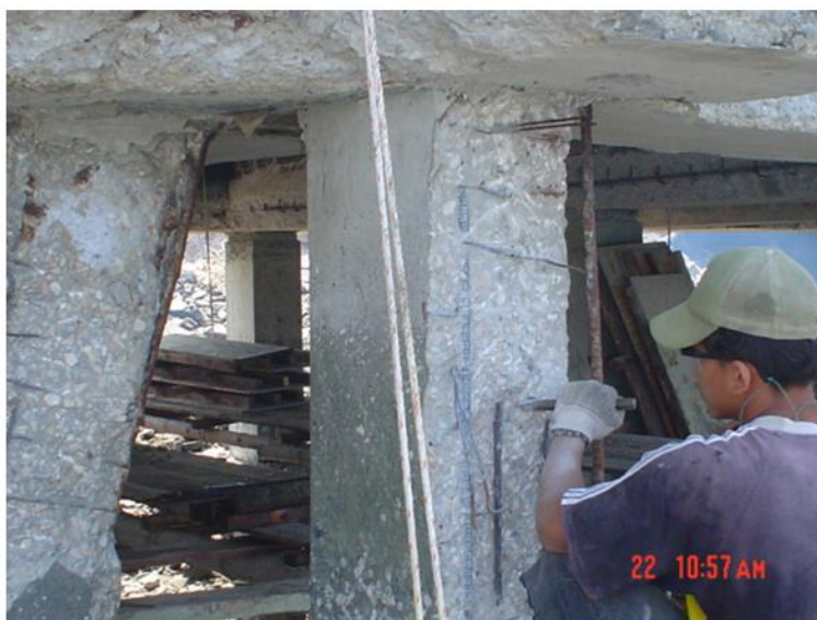
Foto 7: Limpieza, delimitación del área a reparar y eliminación de recubrimientos Fuente: (DINCYP, 2010)
