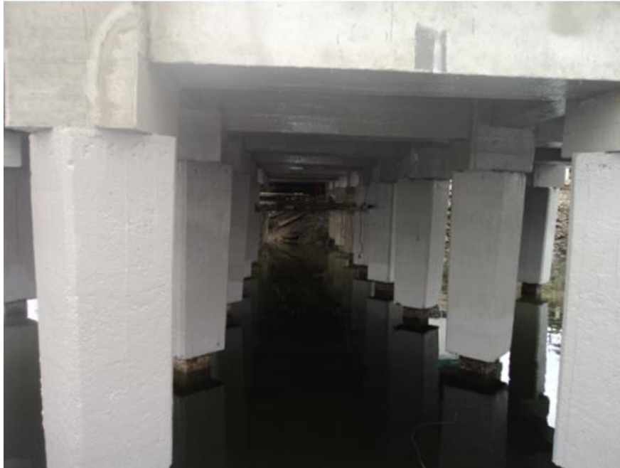
Foto 17: El muelle pintado con recubrimiento a base de resina epóxica Fuente: (DINCYP, 2010)
