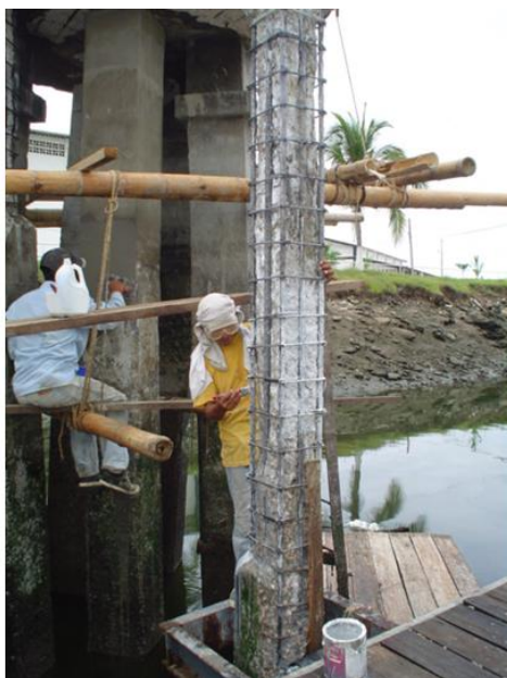
Foto 11: Pintada de la superficie sana del hormigón con adhesivo epóxico para unir hormigón fresco y endurecido.
