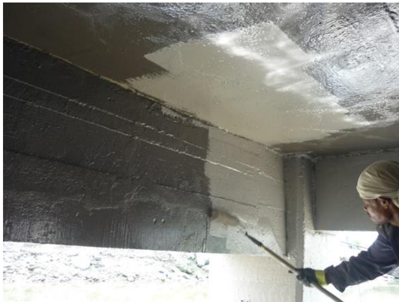
Foto 16: Aplicación tipo pintura de recubrimiento a base de resina epóxica Fuente: (DINCYP, 2010)
