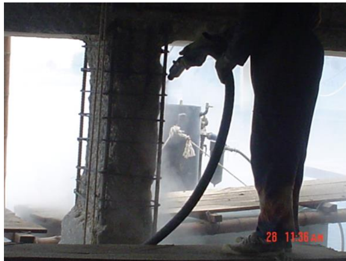
Foto 10: Se realiza limpieza abrasiva en el pilote Fuente: (DINCYP, 2010)
