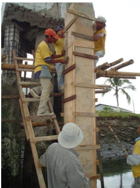
Foto 12: Encofrado del pilote para fundir con mortero expansivo más árido (grout)
