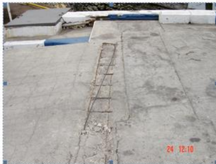
Foto 6: Losa del muelle No 2
