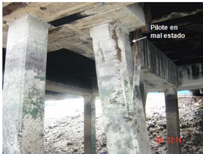
Foto 5: Pilote del muelle No 5
