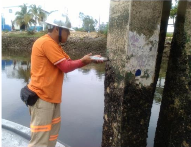
Foto 21: Prueba con el martillo esclerométrico en pilote Fuente: Pruebas y Ensayos realizados por INGEOMAT S.A. 15-08-2016
