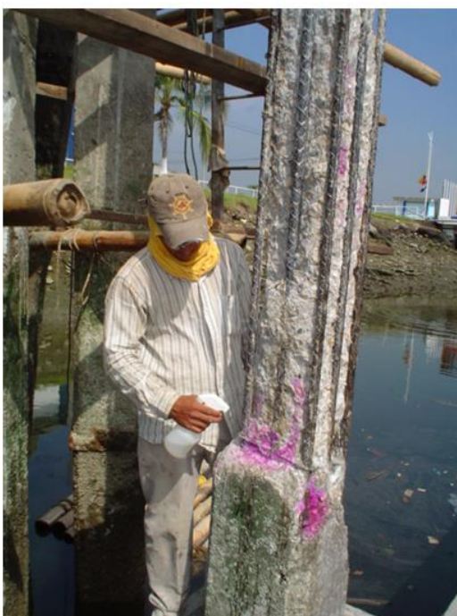
Foto 8: Prueba para determinar la carbonatación en pilote. Aplicando al hormigón del pilote el reactivo de fenolftaleína para verificar haber llegado al hormigón sano. Fuente: (DINCYP, 2010)
