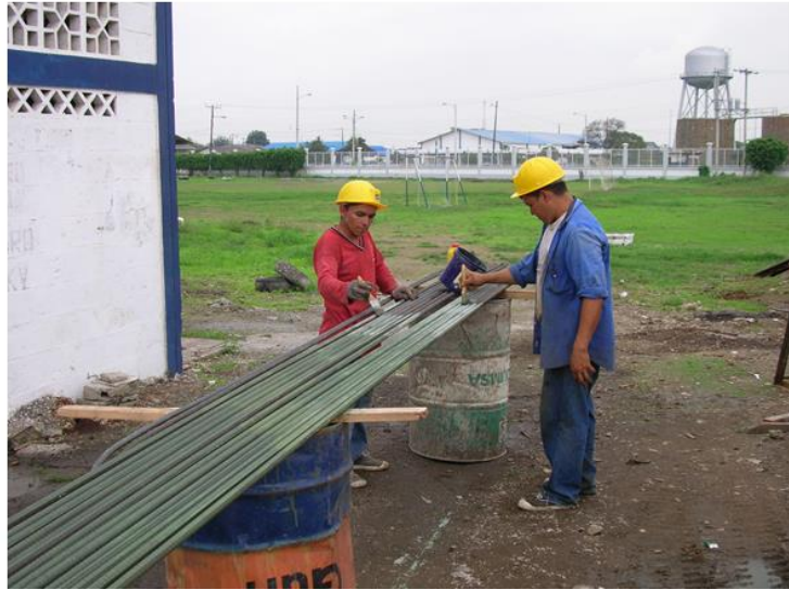
Foto 9: Pintado de varillas de acero con inhibidor de corrosión Fuente: (DINCYP, 2010)
