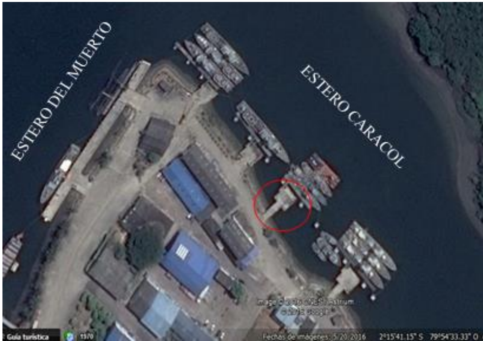
Figura 2. Ubicación Muelle No 2 BASUIL Fuente: (Google Earth, 2016)
