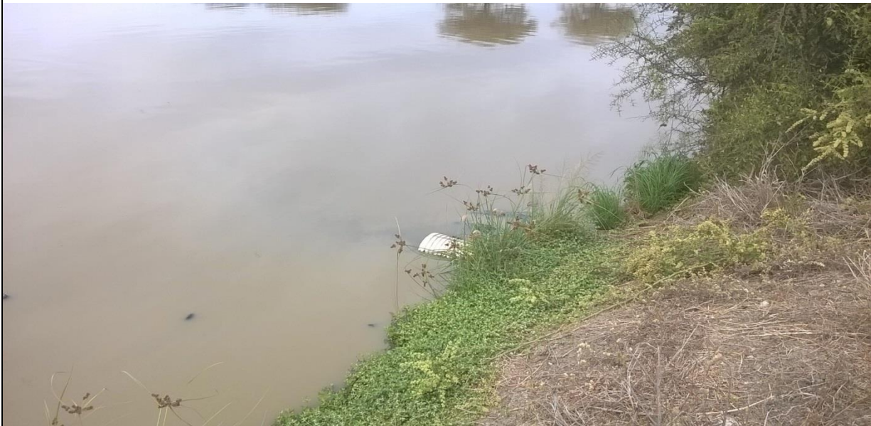
Entrada de agua residual a la laguna de oxidacion
