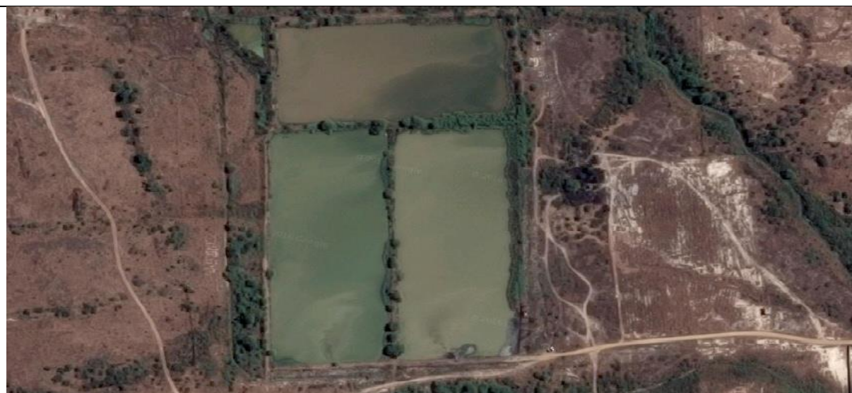
Vista de lagunas de oxidación del cantòn Playas (tomada de Google Eart)
