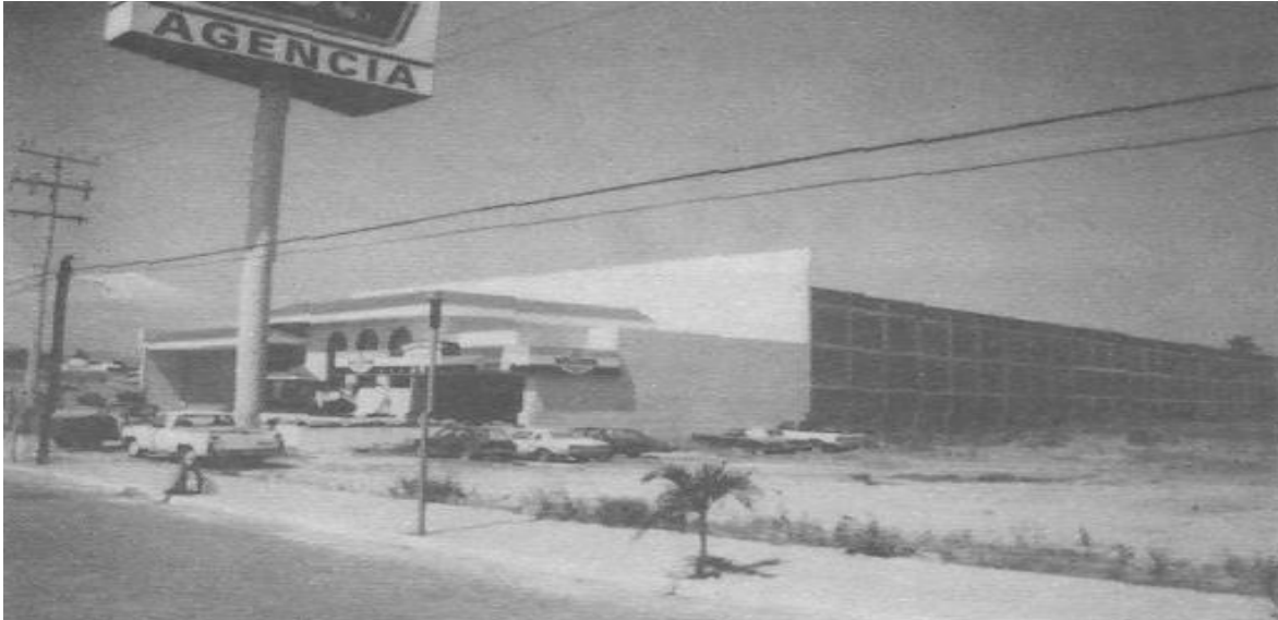
Ilustración 3. Excelente desempeño de muros adecuadamente confinados.
