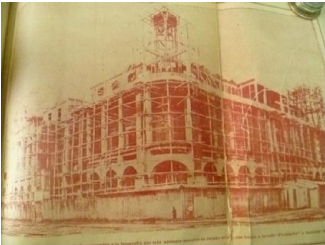
Figura No. 03 – Adelanto de la Obra del Palacio Municipal
