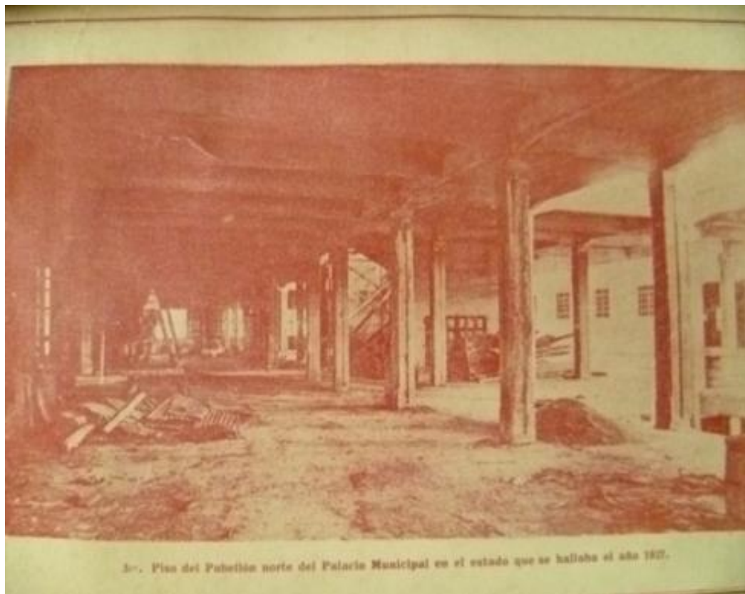
Figura No. 04 – Pabellón Norte en Proceso de Construcción
