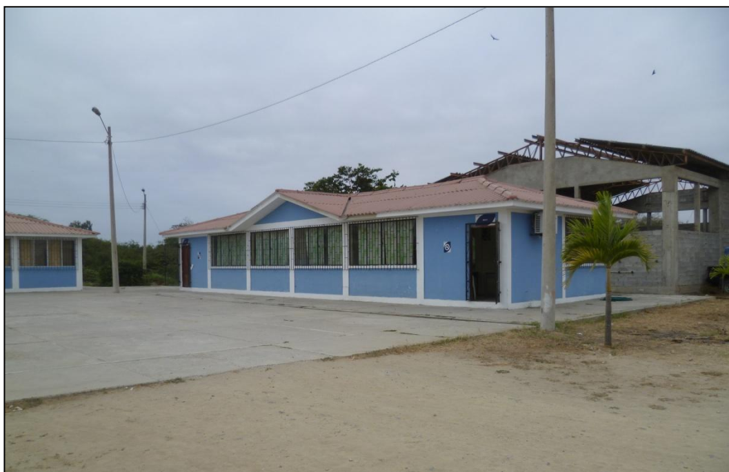
VISTA PANORÁMICA DE LAS INSTALACIONES DEL SECAP
