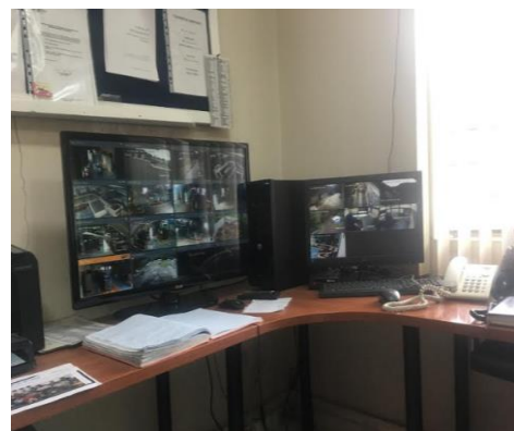
Figura 7: Visita en oficinas SCADA (Fuente: Autor)
