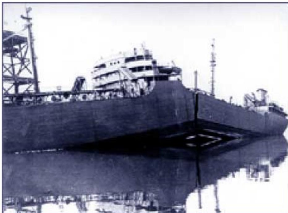
**Barco Schenectady T2 Tanker – Agrietado en dos en 1943 con un mar calmado.**
