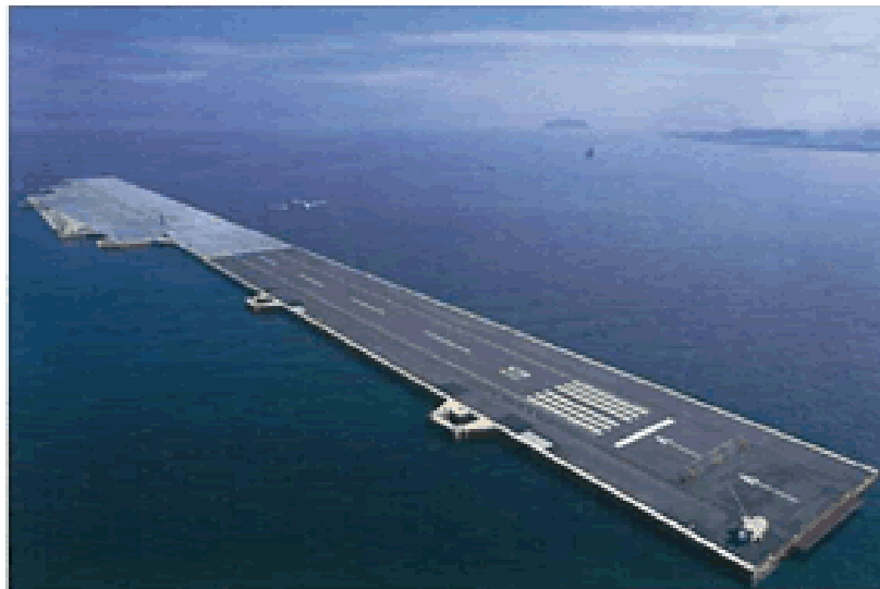
Fig. 1.4 Mega-Float in Tokyo Bay
