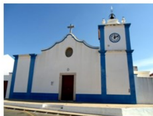
Fachada da Igreja Matriz (Igreja de Nossa Senhora da Graça)
