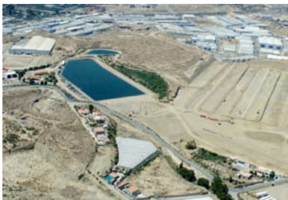
Figura 1. Vista aérea de las instalaciones de la comunidad de regantes Las Cuatro Vegas en Almería. Cortesía de José Antonio Pérez. Comunidad de Regantes Las 4 Vegas. Almería.
