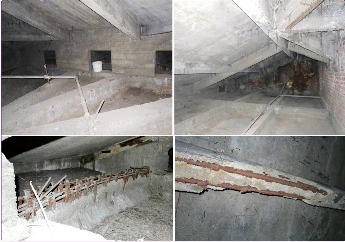
Şekil 23. Çatıdaki kirişlerin Hennebique tekniğindeki donatıları.
