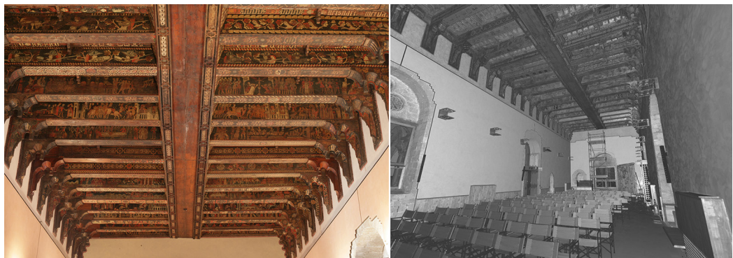
Fig. 1. Foto e anteprima di una scansione laser del soffitto.
