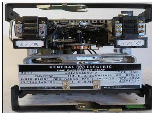
Figura 5. Relevador de sobre corriente 50/51 electromecánico.
