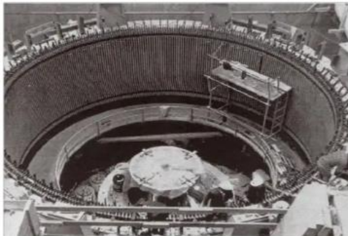
Figura 3.5. Estator de un generador trifásico [16].
