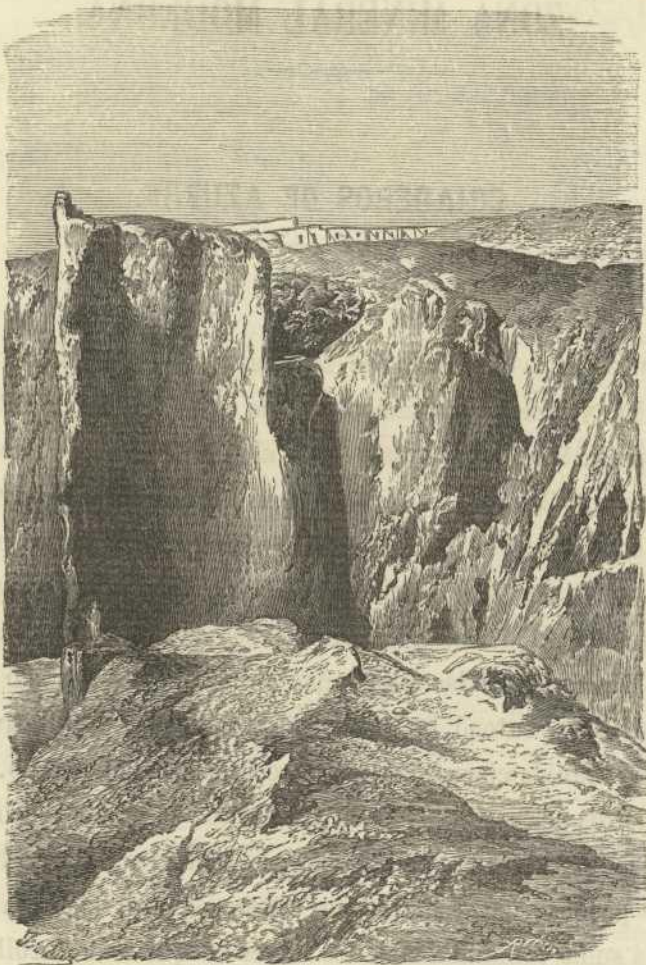
CORTE DE UNA ESCAVACION ANTIGUA EN LAS PEDRERAS VIEJAS.
