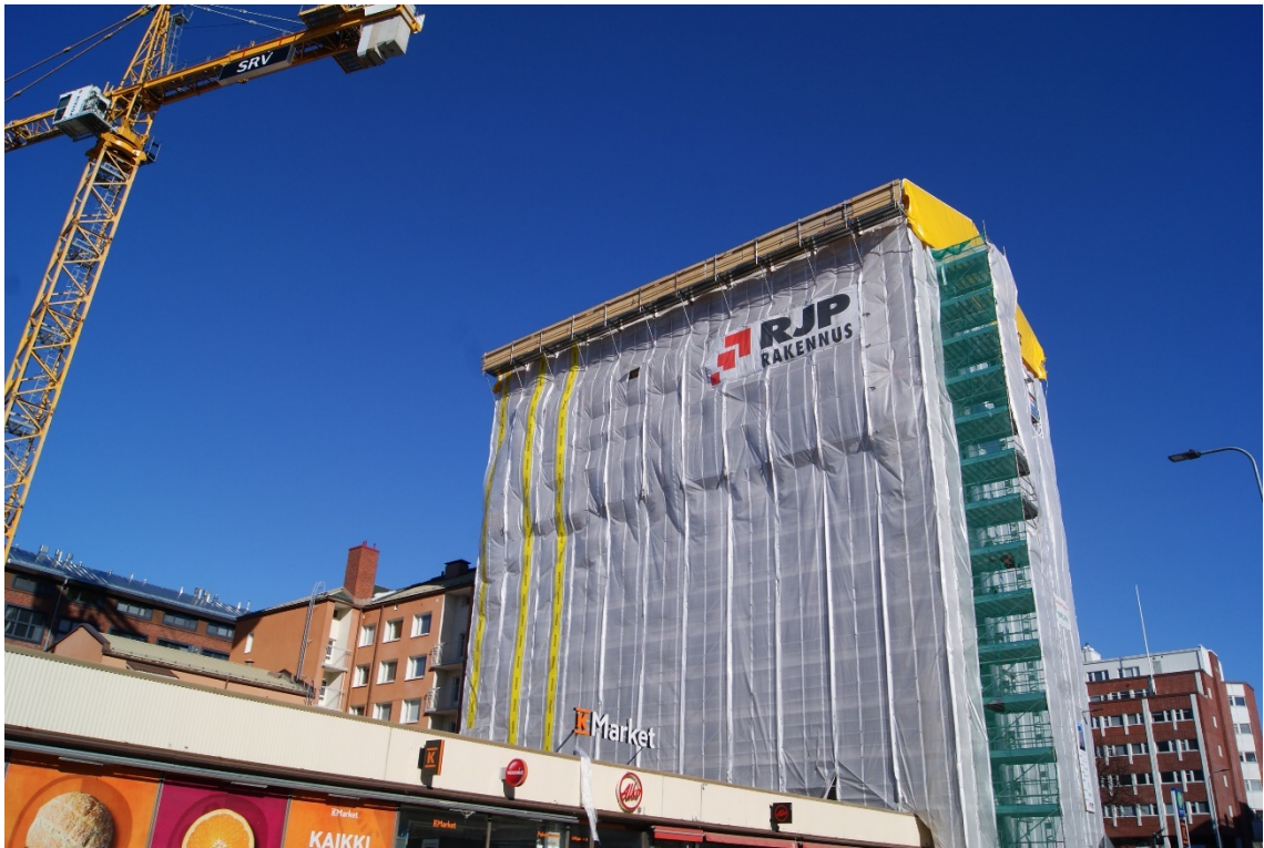
Kuva 52. Tampereen Tammelassa rakennetaan lisäkerroksia sääsuojan alla. Kuva: Dennis Somelar
