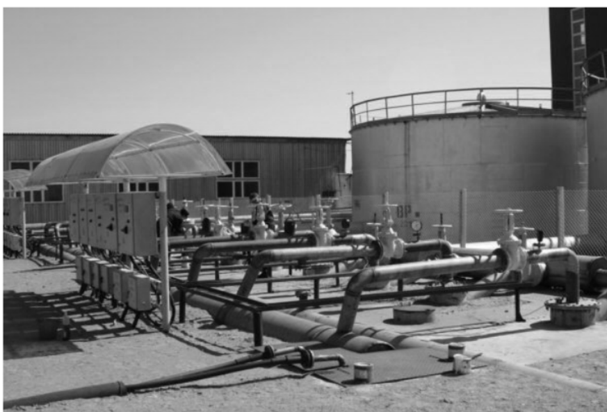
Рис 6.16. Вузли розподілення витравлювального розчину
