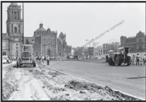
Imagen 17. Construcción de la línea del metro en el Zócalo capitalino, octubre de 1969. Fotografía del Sr. Ignacio Rodríguez Monroy.
