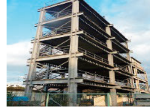
A-3鋼構造実大試験架構
