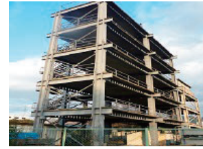
A-3鋼構造実大試験架構
