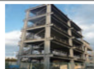
A-3鋼構造実大試験架構
