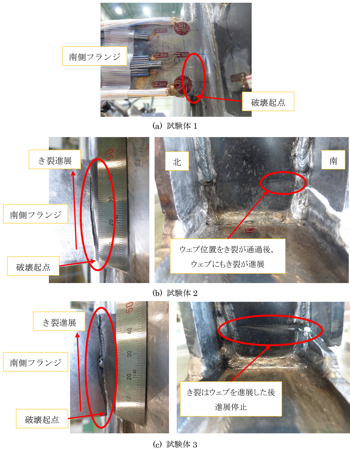
図 3.2-9 各試験体において柱-梁接合部付近に生じたき裂
